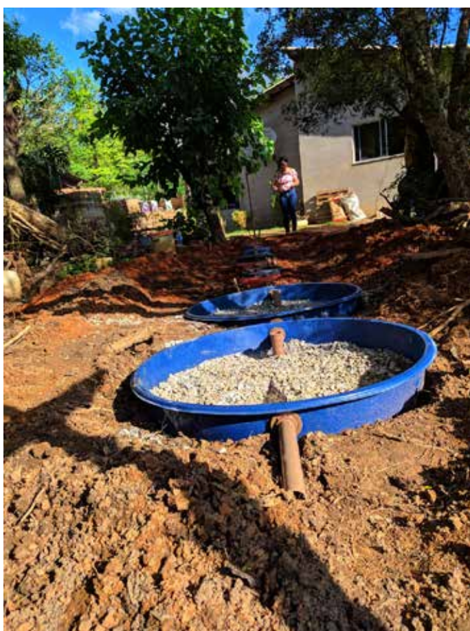
Construção de filtro biológico na propriedade da Milene Torres Guimarães, em Jaboticatubas. Foto: Anna Salles
