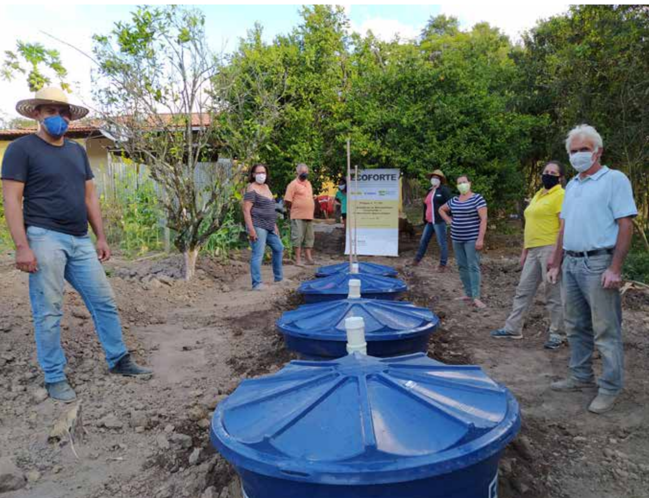
Fossa séptica biodigestora implementada na propriedade da Isabel Umbelina, em Bonfim. Foto: Anna Salles
